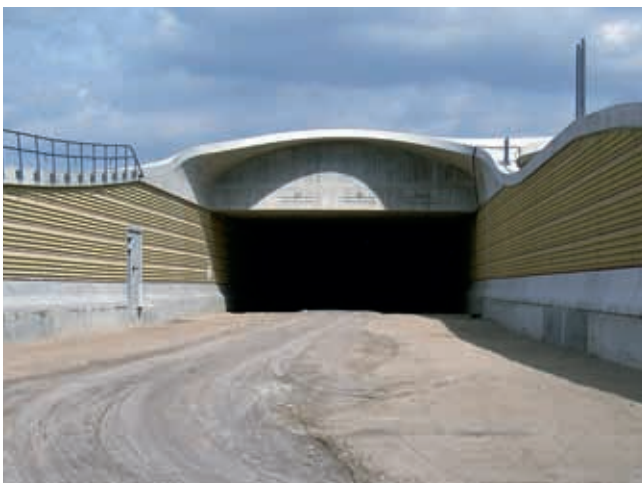
Abbildung 5: Auch in Troglagen und an Tunnelleinfahrten kommen Sonalith-Lärmschutzelemente zum Einsatz
