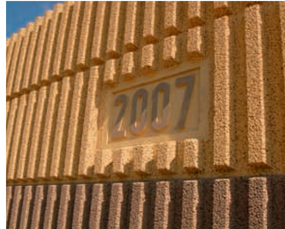
Abbildung 2: Profilierungen lassen sich auch in senkrechter Form gestalten. Zusätzliches Element ist bei diesem Beispiel das in die Struktur integrierte Baujahr
