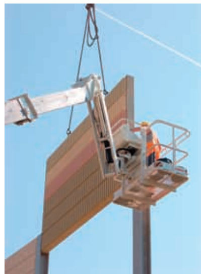
Abbildung 6: Zur Montage werden die einzelnen Beton-elemente mit dem Kran an ihren Platz gehoben
