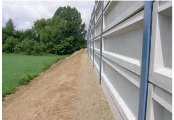
Abbildung 4: Die Befestigung der Schallschutzelemente erfolgt in der Regel an Pfeilern. Die einzelnen Elemente werden zwischen den Pfeilern montiert
